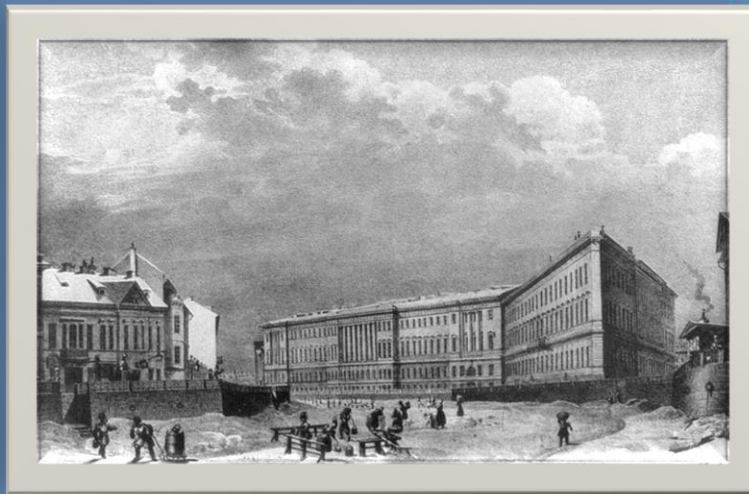
МИД, Санкт-Петербург, набережная реки Мойки, 43
